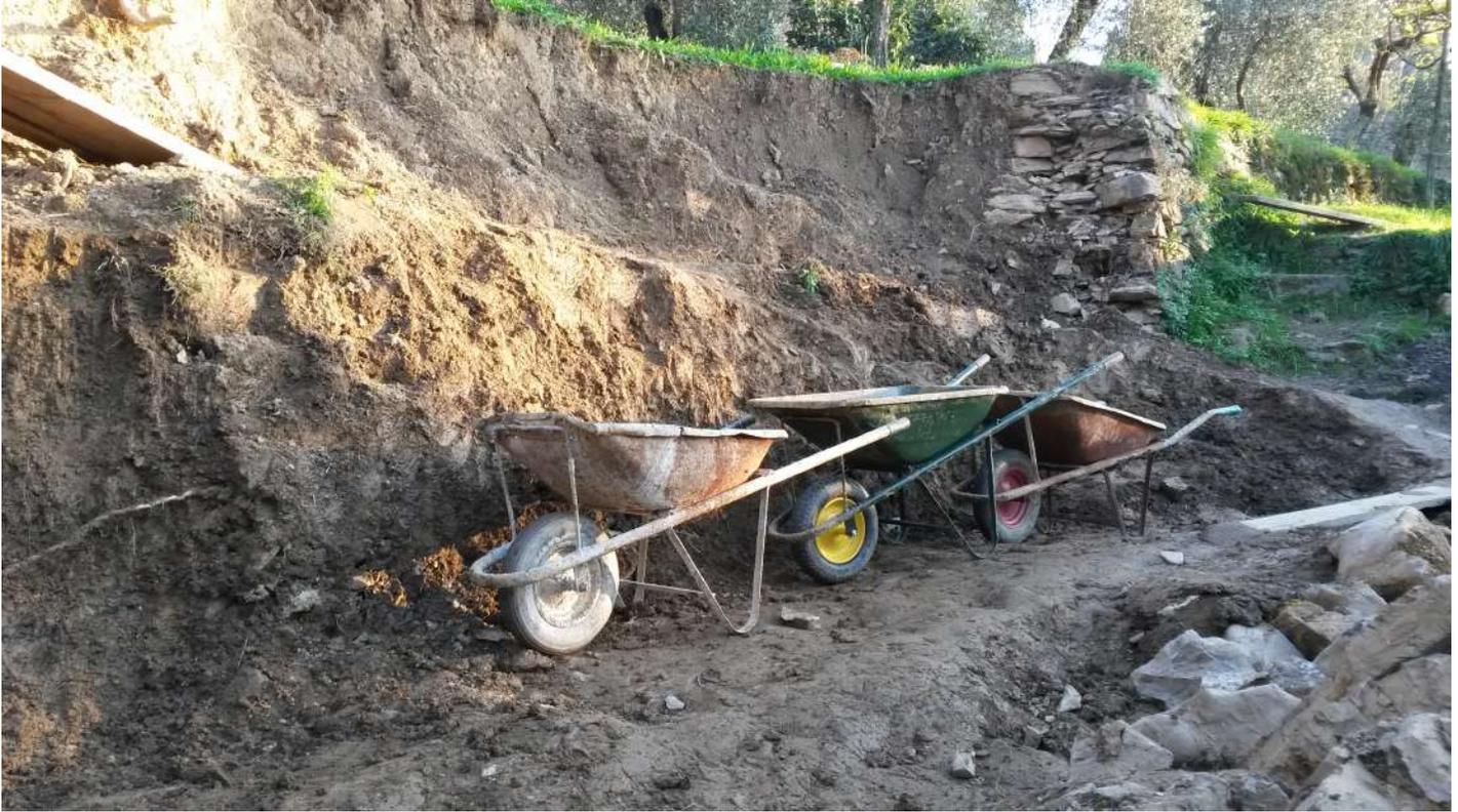
Abbiamo dovuto ri-scavare a *picco e pala*, cioè a mano come si dice in gergo, tutto il muro sino alle fondazioni e creare un sentiero nello scavo per portare la terra a monte. La quantità di terra coprieva per un metro di profondità e tre di larghezza la fascia superiore al muro per circa 30 metri lineari, e ciò che non è stato riutilizzato per riempire la dorsale del muro stesso, è ancora oggi lì da vedere.
