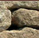
Pierre de la maçonnerie à part entière, elle doit remplir les mêmes conditions (figures 36 et 37). Elle croise en façade et à l'intérieur du mur avec les pierres voisines afin de ne pas créer de coup de sabre. Elle est calée et insérée dans la maçonnerie selon les mêmes critères. Et elle a aussi l'inclinaison donnée par le fruit du mur (figure 38).
